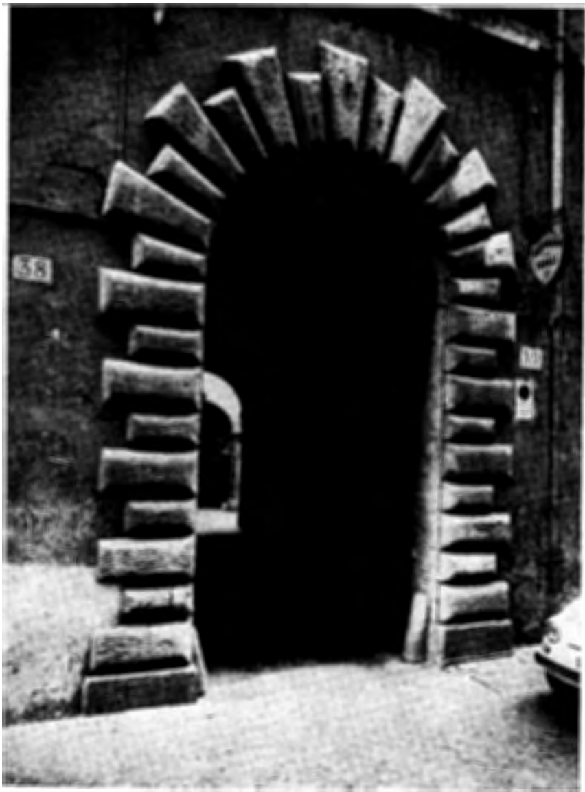
Ingresso del palazzetto Conti (già Aldobrandini) in via dei Banchi Nuovi.
