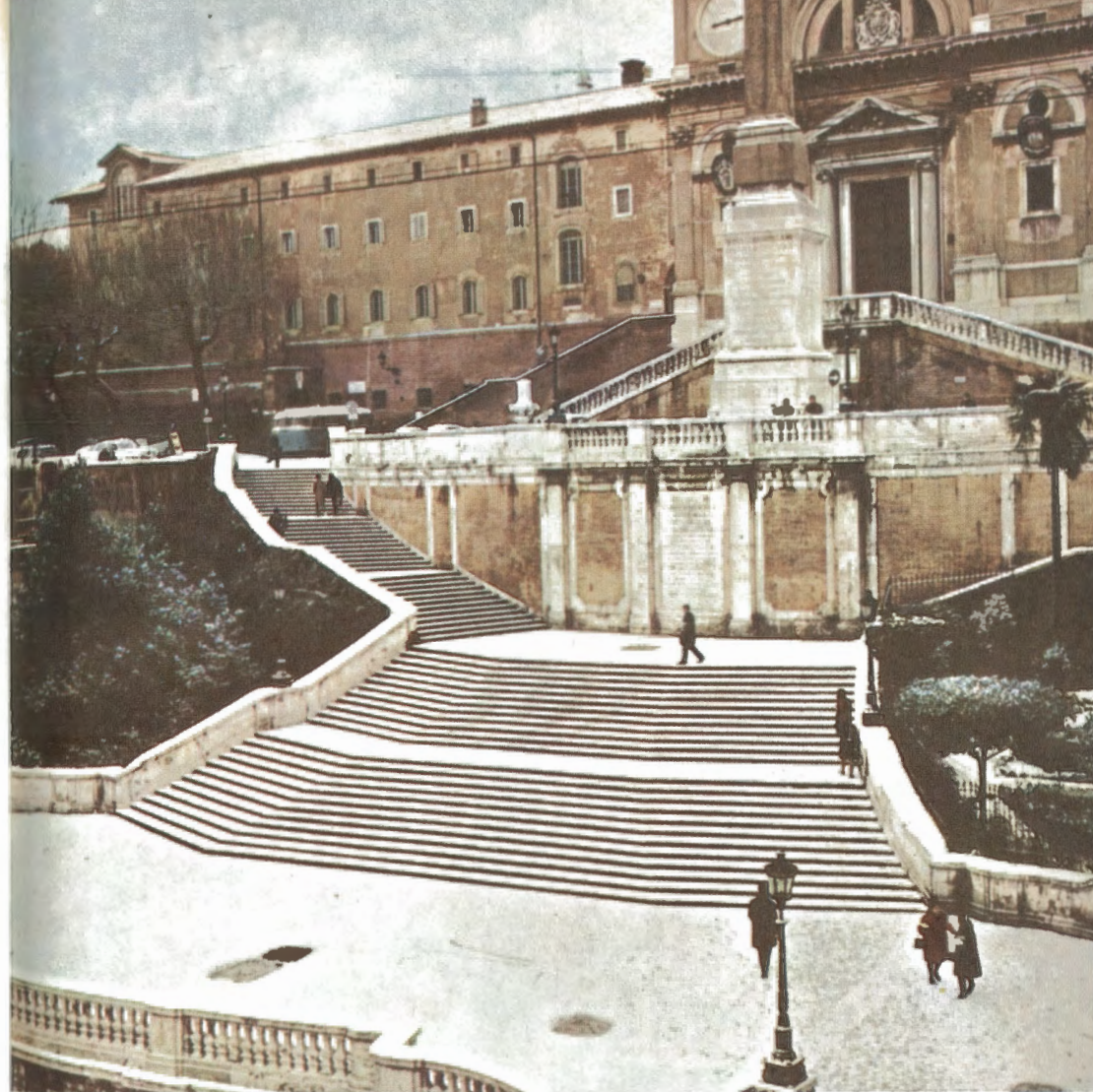
La « Trinità » sotto la neve vista, al risveglio del 9 febbraio 1965, dall'Osservatorio dell'A. (Dietro il tetto del Convento è ben visibile la « gru » edilizia che fu in sito dal 1962 al 1965).
