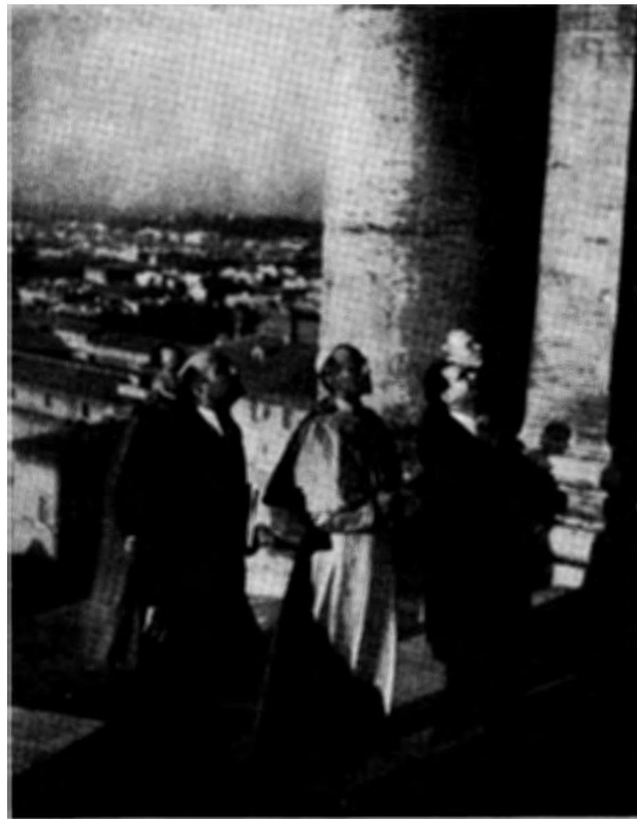
12 settembre 1942: Pio XII, accompagnato dal Sostituto, mons. Montini, visita i lavori ai finestrini della cupola, illustratigli dal prof. Nicolosi (alla sinistra e alla destra del Pontefice sono rispettivamente mons. Kaas, Segretario-economista della Fabbrica, e il conte Galeazzi, architetto dei Sacri Palazzi e attuale Decano degli architetti).
